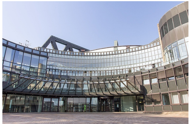
> Neufassung der nordrhein-westfälischen Bauordnung in Kraft getreten
